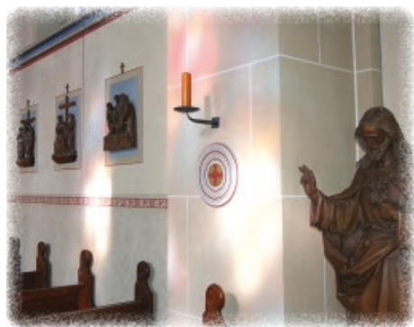
Bereits nach Beseitigung von Feuchtigkeitsschäden fertiggestellte Malerarbeiten im Bereich des linken Seitenschiffes.
